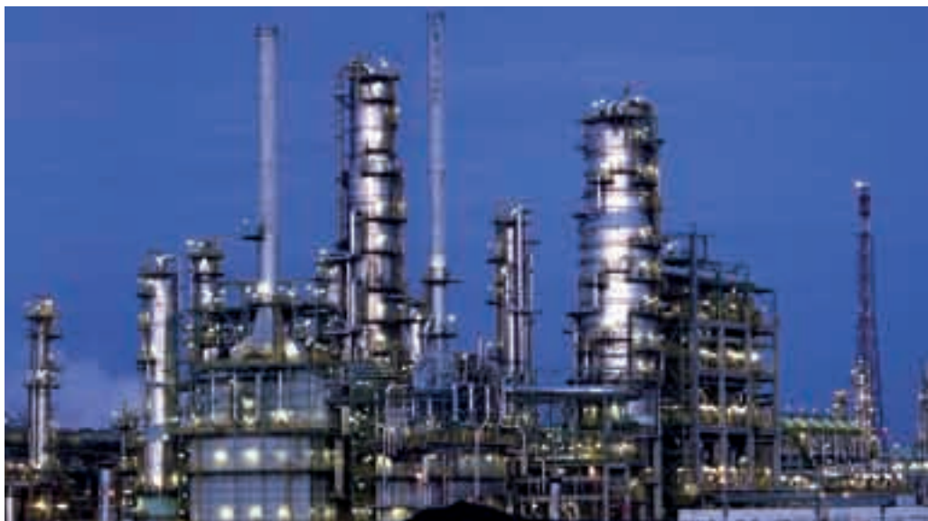
Die Zumischung von Bioethanol zu herkömmlichen Ottokraftstoffen erfolgt in Raffinerien der Mineralölindustrie.
